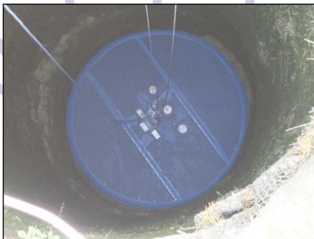
Figure 1 - Obturateur gonflable en place – Puits Ste Barbe - Bézenet
