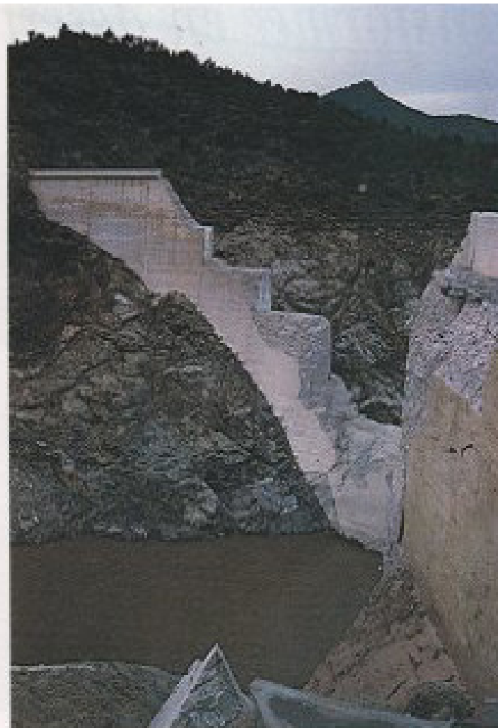
Avant Après Insuffisance de l'assise de l'ouvrage sur les rochers
