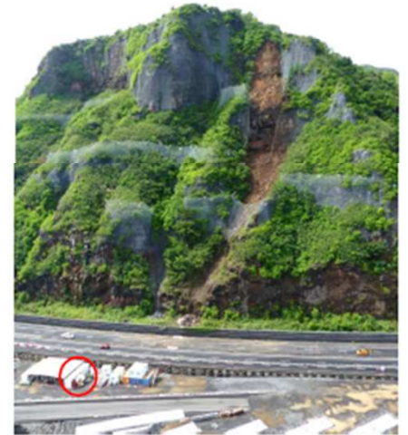
Un évènement chute de blocs
