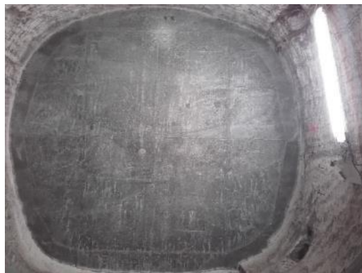
Le barrage après décoffrage
