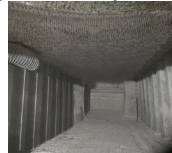
BAP après décoffrage et havage pilier central barrage double
