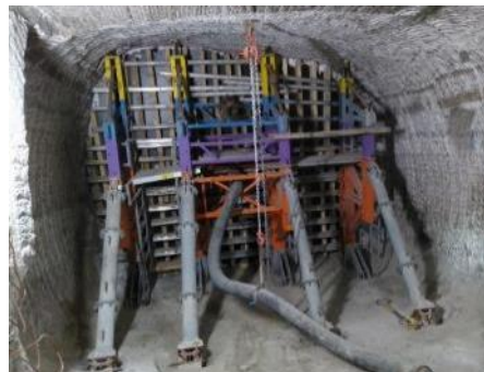
Coffrage final + injection BAP
