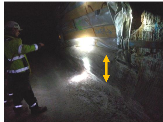
Soufflage du mur
