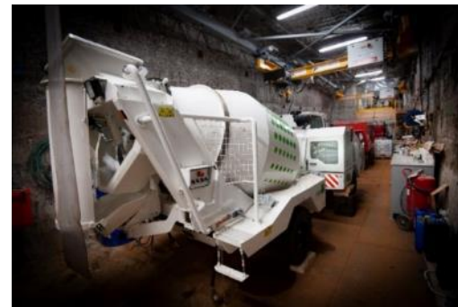
Toupie pour les bétons de barrage
