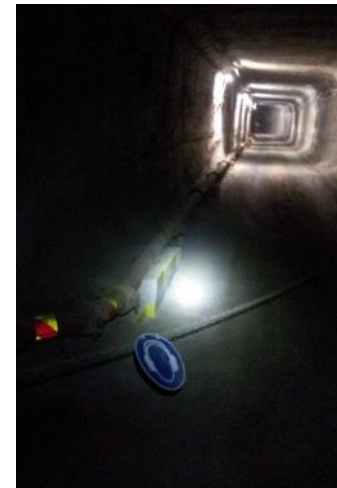
Conduite horizontale pour les coulis de remblayage
