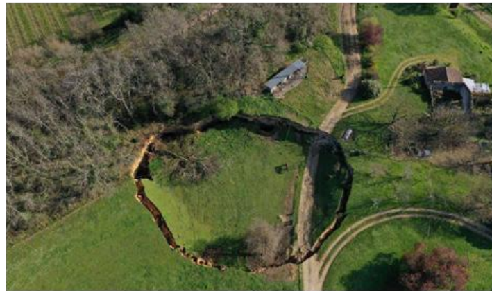
Effondrement en masse
