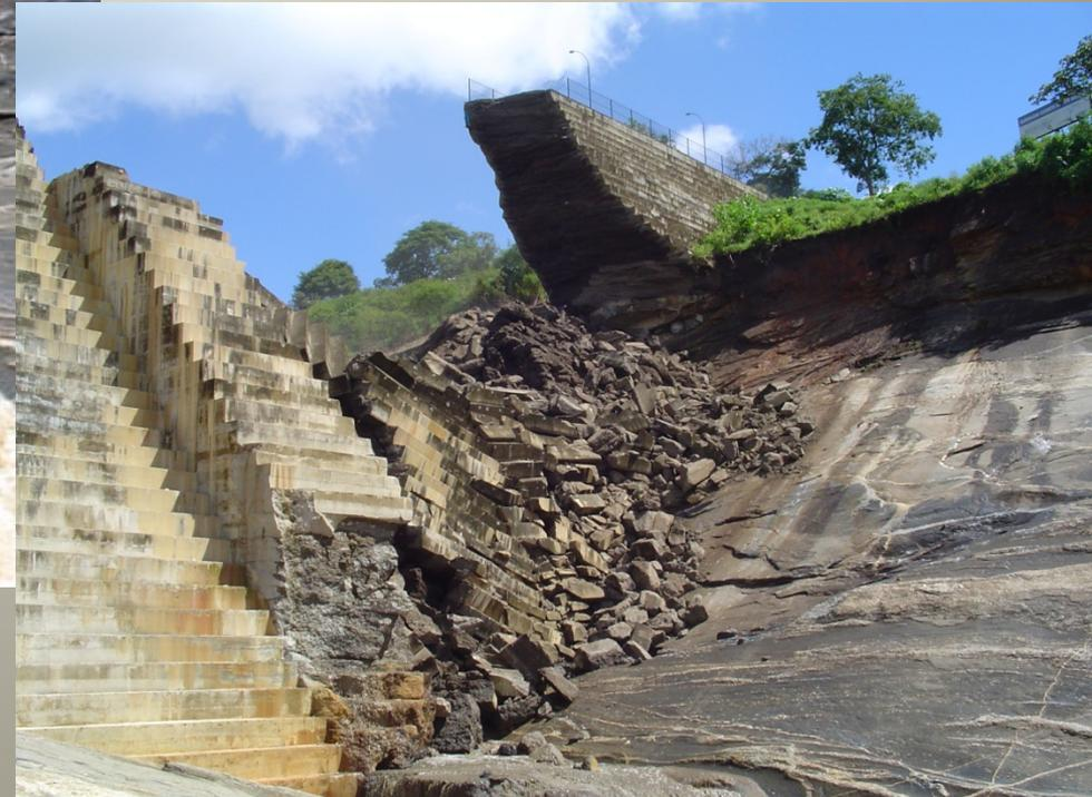
Rupture sur une surface de glissement dans la fondation
