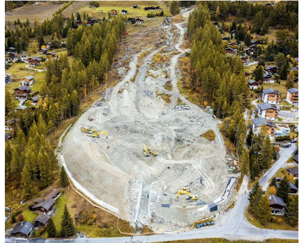
Dépotoir du torrent Peterey en phase de construction (Zinal). Source: Olivier Maire, LeTemps.
