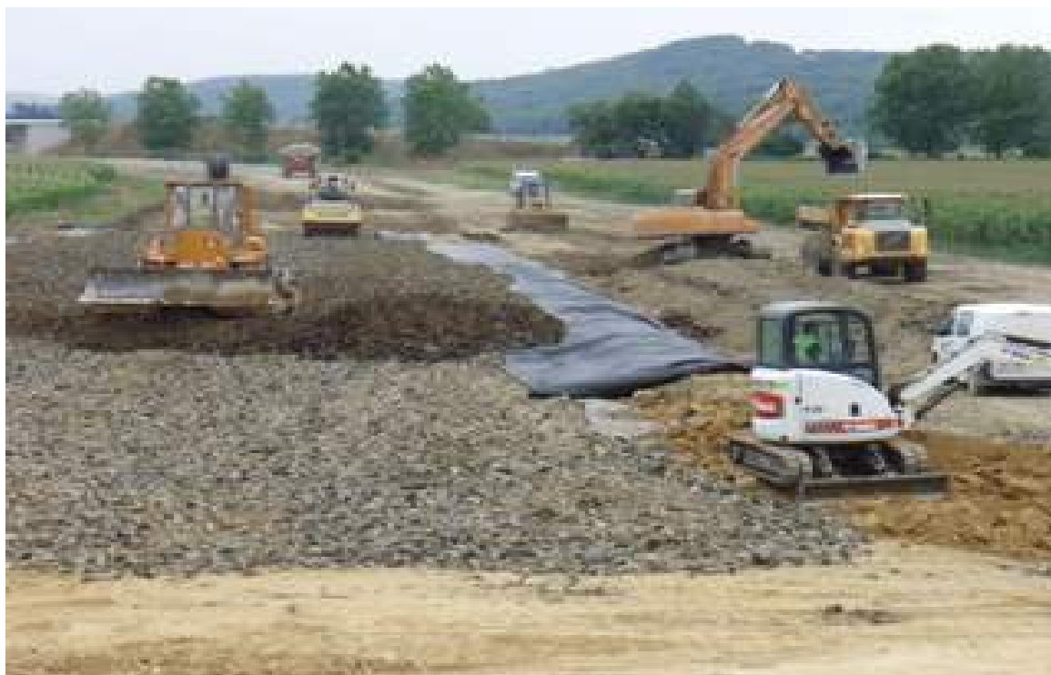
Figure 4. Vue générale du chantier - préparation d'un burrito
