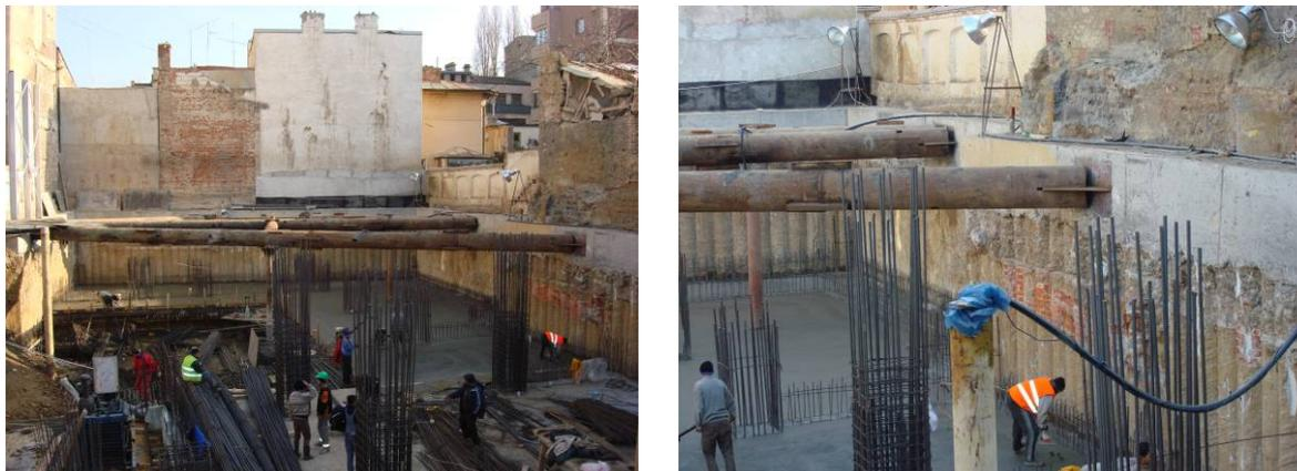
Figure 2. Photos de la paroi de soutènement
