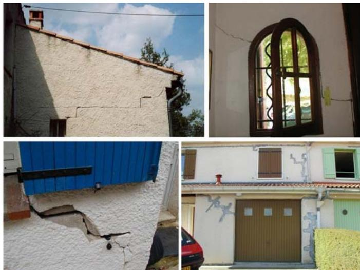
Figure 2 – Quelques exemples de sinistres liés au retrait-gonflement des argiles
