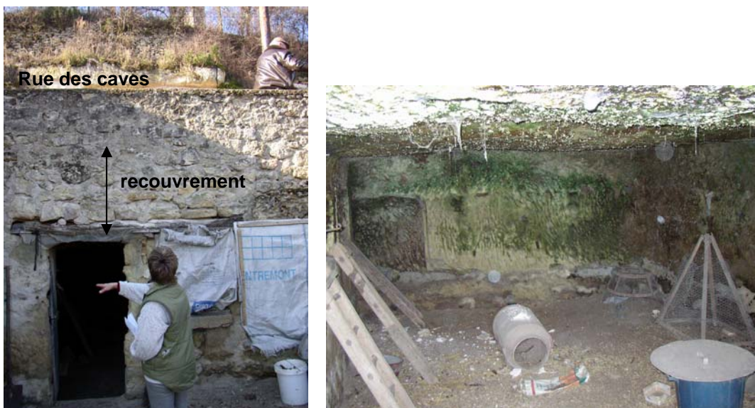
Figure 3 et 4 : vue de l'entrée et de l'intérieur de la cave n°5 (stable) à Ferrière-Larçon
