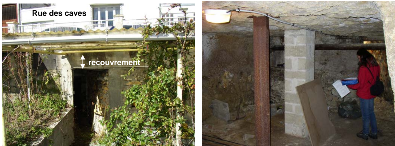
Figure 5 et 6 : vue de l'entrée et de l'intérieur de la cave n°15 (instable) à Ferrière-Larçon et faisant déjà l'objet de confortements.
