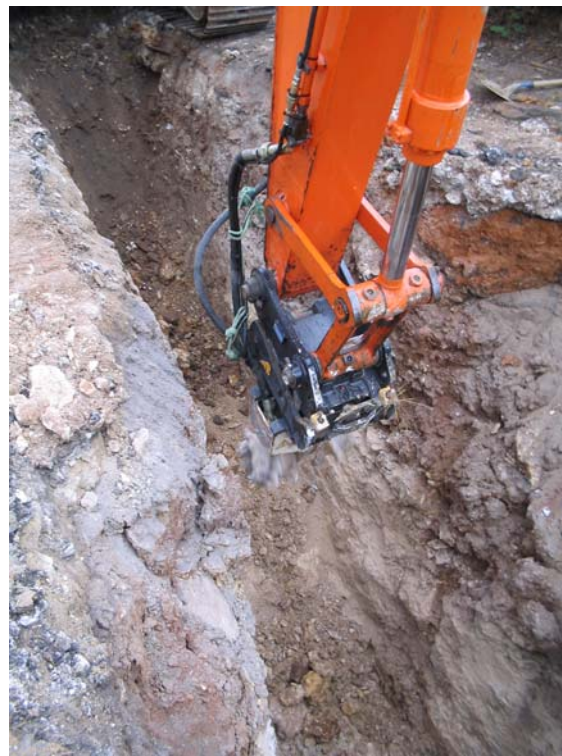
Figure 10 et 11 : l'outillage spécifique proposé par l'entreprise SADE pour les travaux d'excavation dans la rue des Caves
