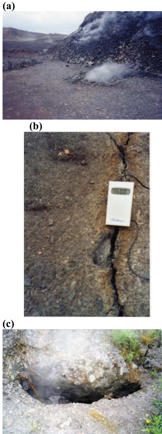
Fig.5. (a) Emission de gaz d'un trou ouvert par la combustion dans le terril n°76. (b) Fente d'ouverture en surface due à la combustion dans le terril n°76. (c) Développement d'une ouverture circulaire dans le terril n°83.
