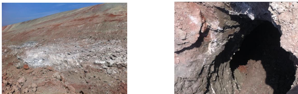
Figure 4: Présence du gypse sur le talus et cavité repérée sur le lot 35.
