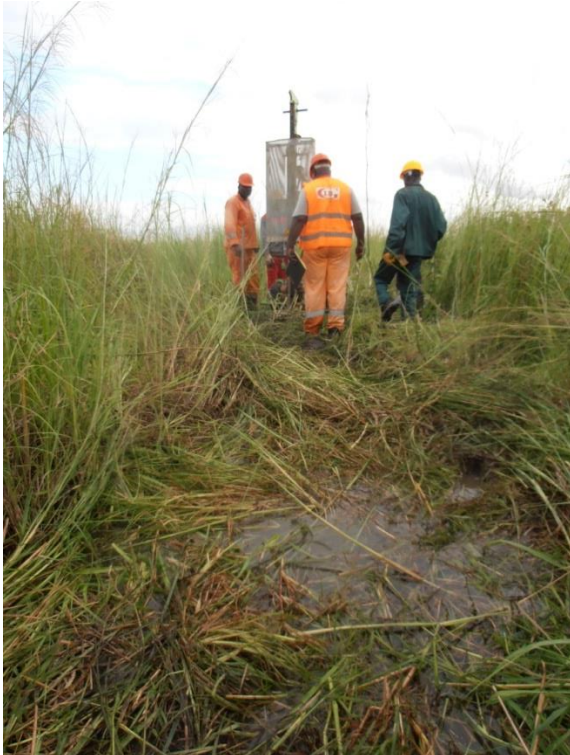
Figure 5 : utilisation du pénétromètre dynamique de type B dans les zones marécageuses
