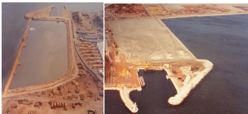
Figure 6 : Situation avant et après un remblaiement des terre-pleins.
