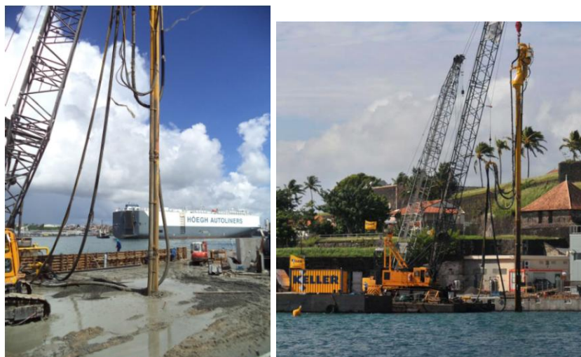
Figure 13: Amélioration de sol par colonnes ballastées on-shore et off-shore.
