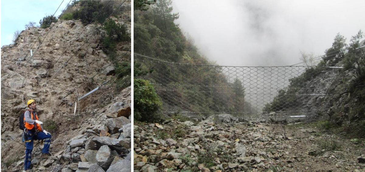
Figure 7 : dissipateur sur ancrages câbles et ouvrage en cours d'installation
