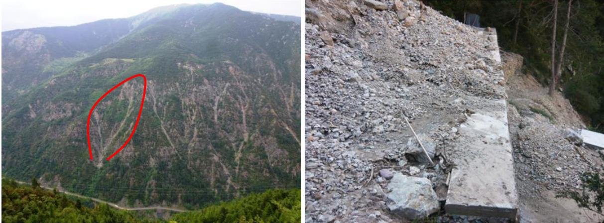
Figure 3 : vue du bassin versant - seuils surplombant la route RM 2205 (ONF).
