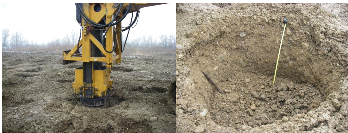
Figure 5. Point d'impact du RIC - cratère profond de 90 cm
