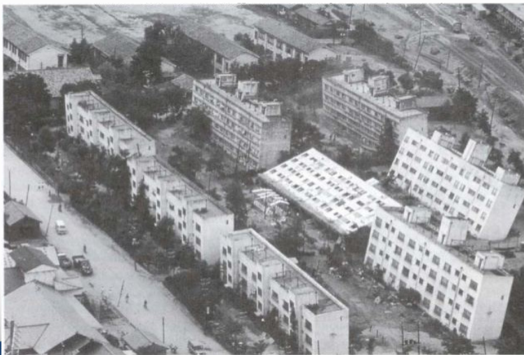
Effondrement par Liquéfaction. Séisme de Niigata (1964) – (USGS)
