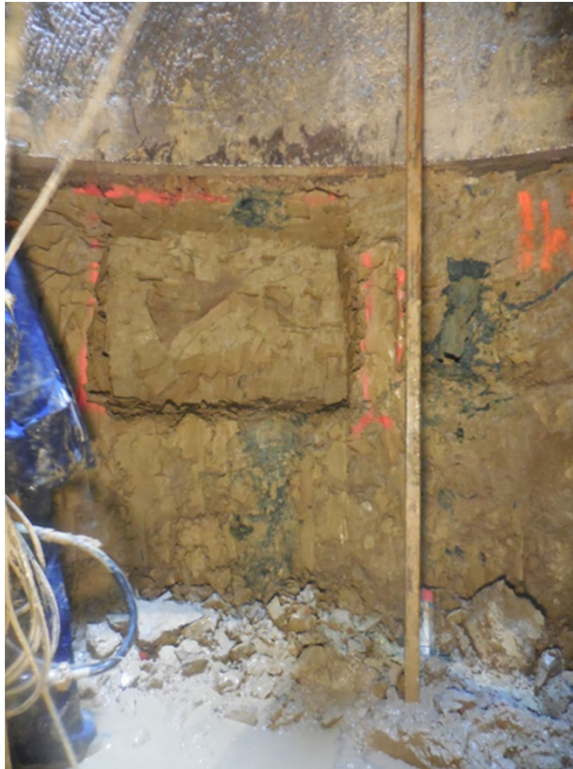
Puits d'essai à Arcueil dans les Argiles Plastiques (L15 sud)
