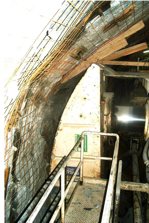
Difficulté de grippage du tunnelier
