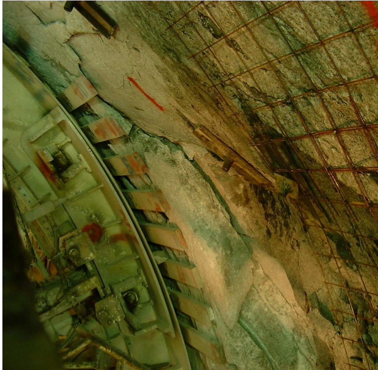
Intensification de la purge et des mesures de protection par ancrages, treillis puis béton projeté à l'avancement
