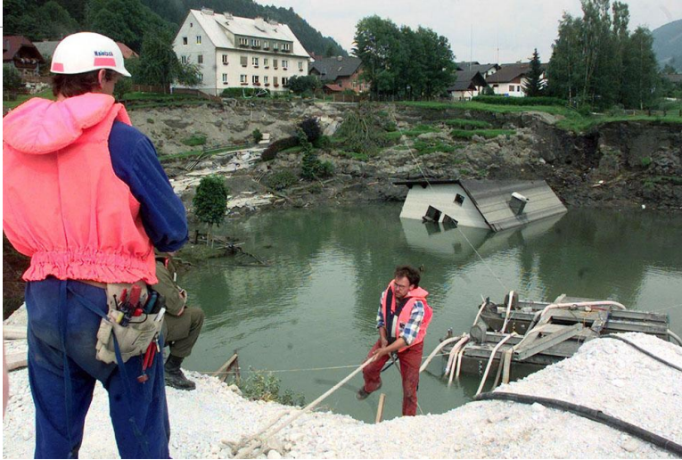
Fontis généré par la mine de talc de Lassing en Autriche
