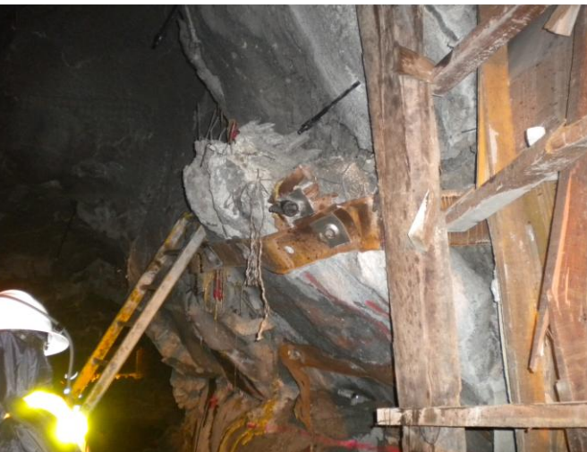
Contraintes sur une galerie de block caving
