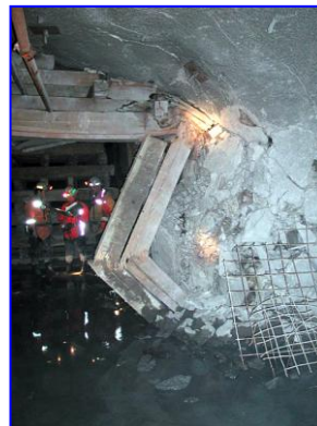
Contraintes sur une galerie de block caving
