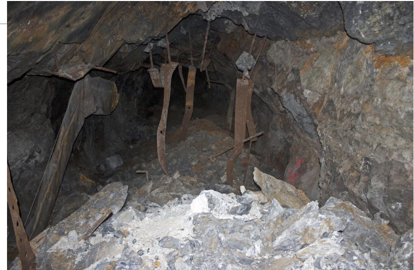
Eboulement en roche massive
