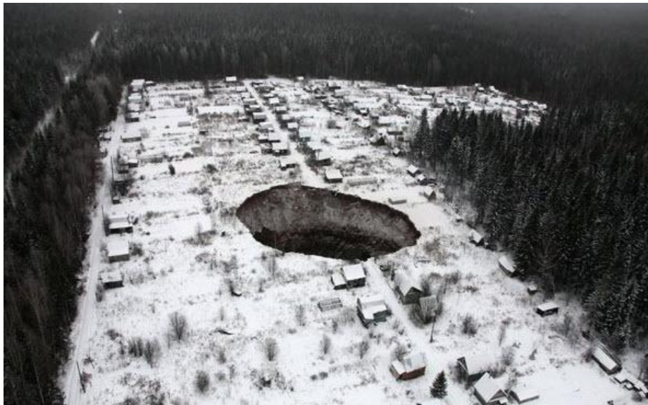
Fontis généré par la mine de potasse de Solikamsk en Russie
