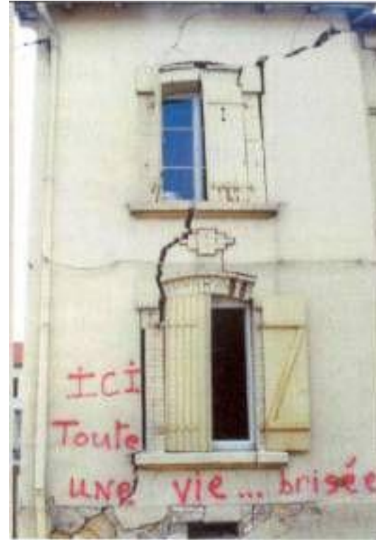
Affaissement de surface en Lorraine
