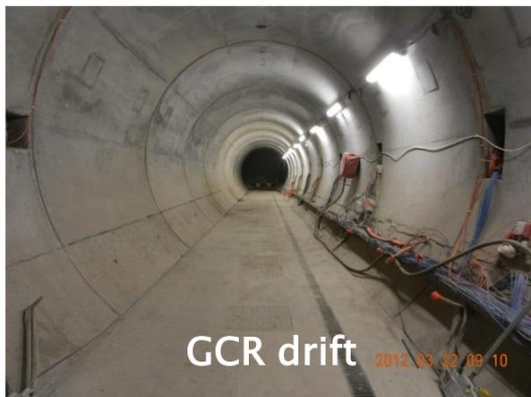
Béton coulé en place 6,5 mois après le creusement
