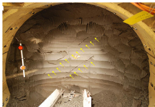
Front d'excavation dans l'argile de Boom - galerie de diamètre 2.5 m (Van Marcke and Bastiaens, 2010)
