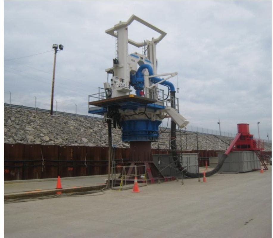
Après la phase de forage dirigé, des pieux de 1,30m de diamètre sont installés tous les 0.8m c/c afin d'assurer le recouvrement et l'épaisseur minimum à 84m de profondeur.
