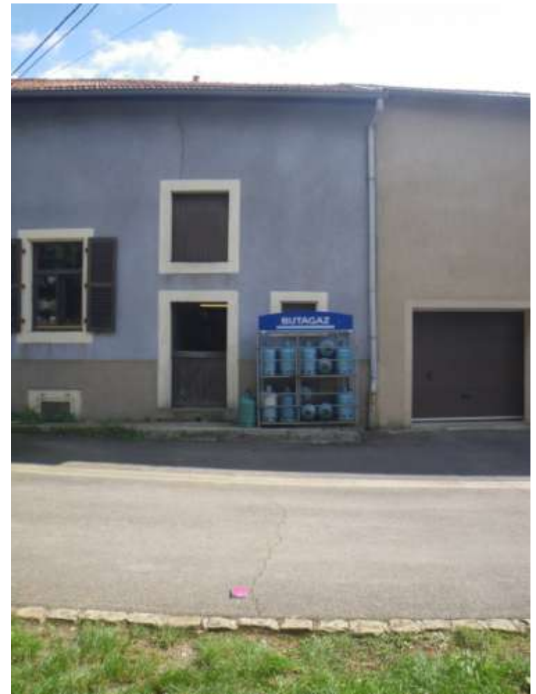
Désordres devant le 381 rue de Fontoy : fissure en façade qui se prolonge sur la chaussée et au mur en face de l'habitation
