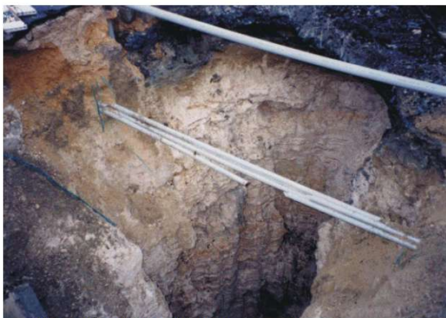
Phénomène de dissolution du gypse suite à une rupture de canalisation. Source : LREP
