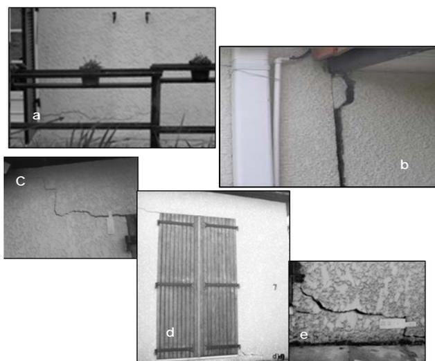
Figure 3 : Type de fissures observées sur les habitations sinistrées du quartier Cap de Bos (M. Chrétien, 2010)
