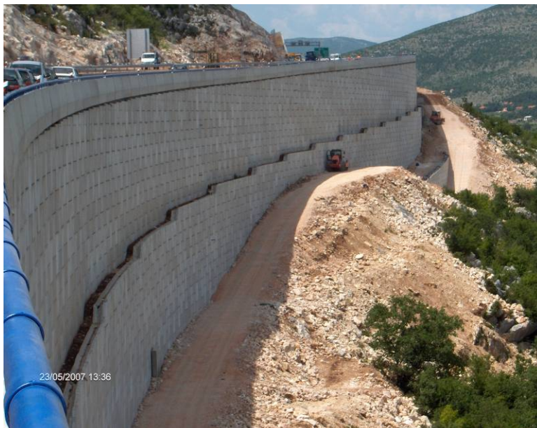
Figure 1 : photo du mur de Strikici lors de la mise en service de l'autoroute
