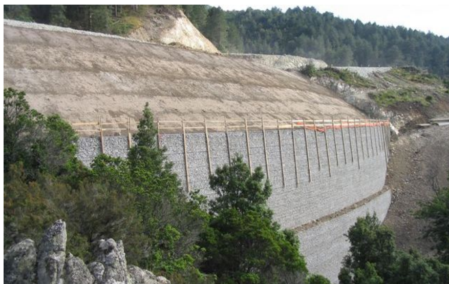
Figure 5 : photo de l'ouvrage avec la mise en œuvre des talus supérieurs
