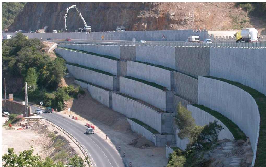
Figure 3 : photo de l'ouvrage durant la construction du mur supérieur
