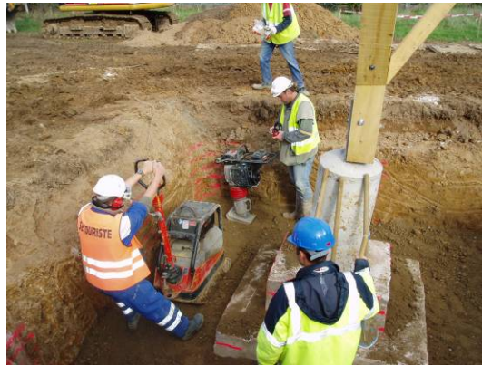
Figure 4 : Réalisation de la dalle
