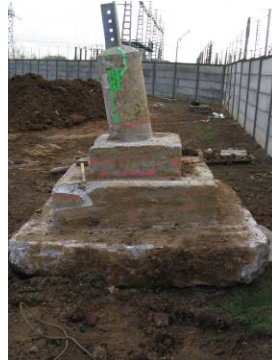
Figure 1 fondation de pylône excavée
